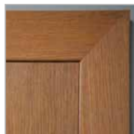
łączenie opasek pod kątem 45°
