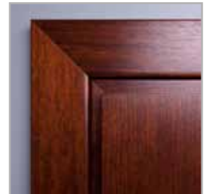
łączenie opasek pod kątem 45°
