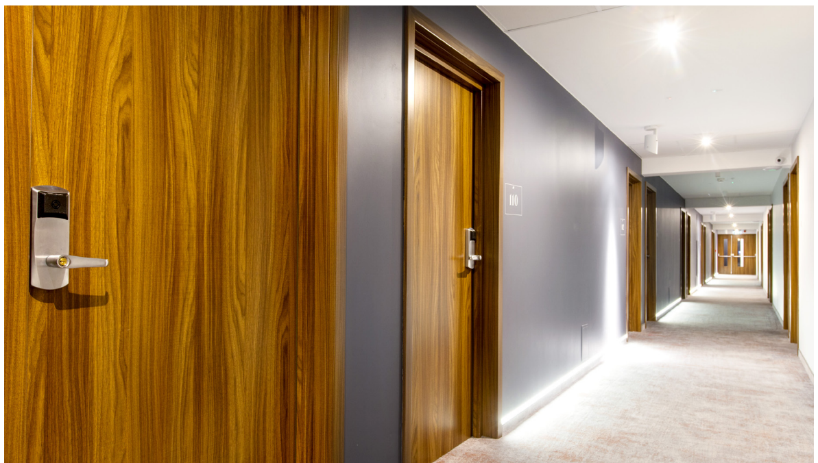
drzwi SR 37 dB, ościeżnica drewniana regulowana
