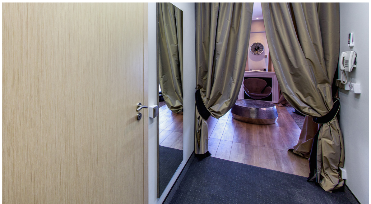
drzwi EI30 PLUS jednoskrzydłowe, ościeżnica stała drewniana
