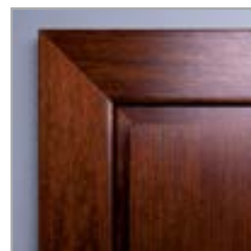
łączenie opasek pod kątem 45°
