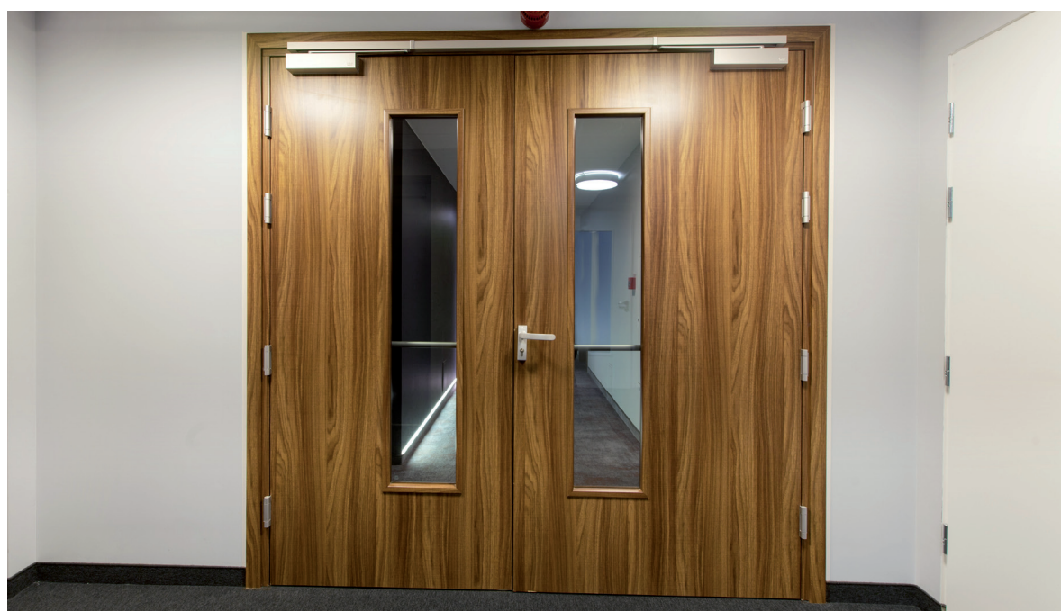
drzwi przeciwpożarowe FR EI30, ościeżnica stała drewniana
