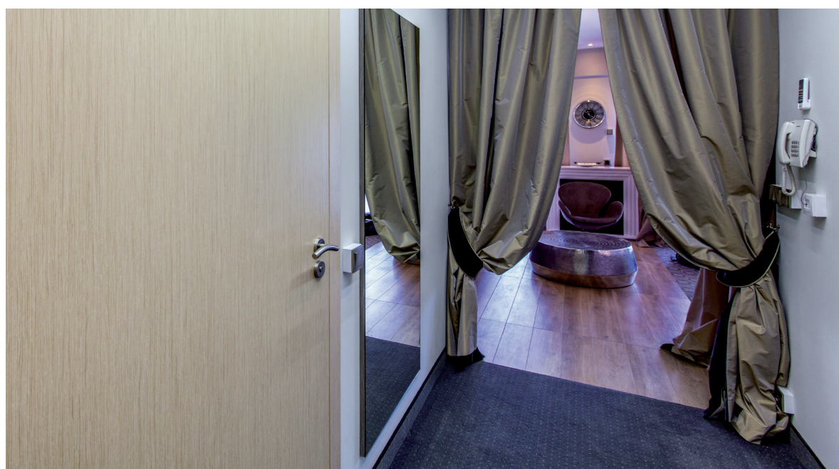
drzwi EI30 PLUS jednoskrzydłowe, ościeżnica stała drewniana
