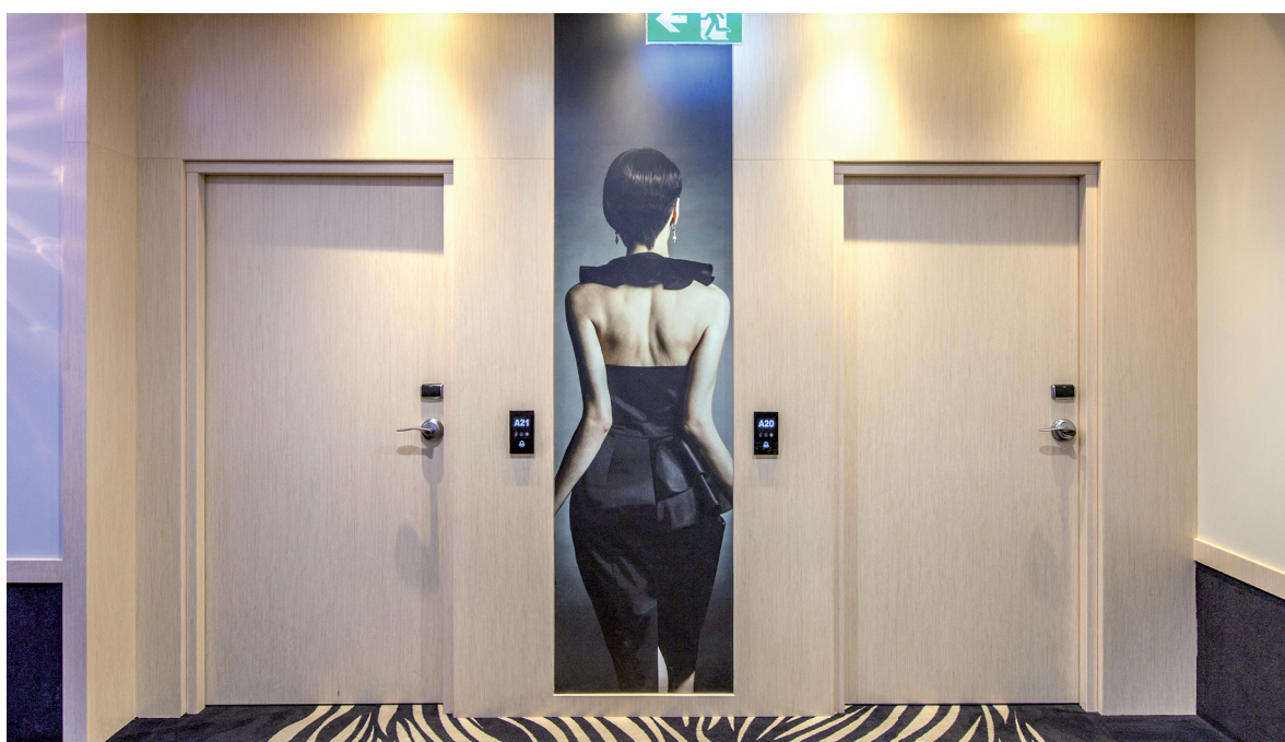
drzwi przeciwpożarowe FR EI30, ościeżnica stała drewniana
