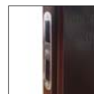
zaczep w skrzydle drzwiowym biernym
