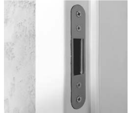
zaczep zamka magnetycznego w ościeżnicy
