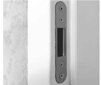
zaczep zamka magnetycznego w ościeżnicy
